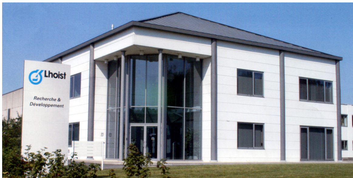
Рис. 4 – Здание офиса со стенами из газобетонных панелей
