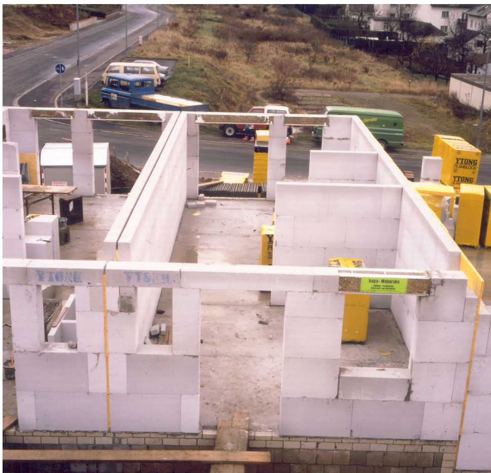
Рис. 3 Строительство дома с использованием крупных блоков и армированных конструкций из автоклавного газобетона
