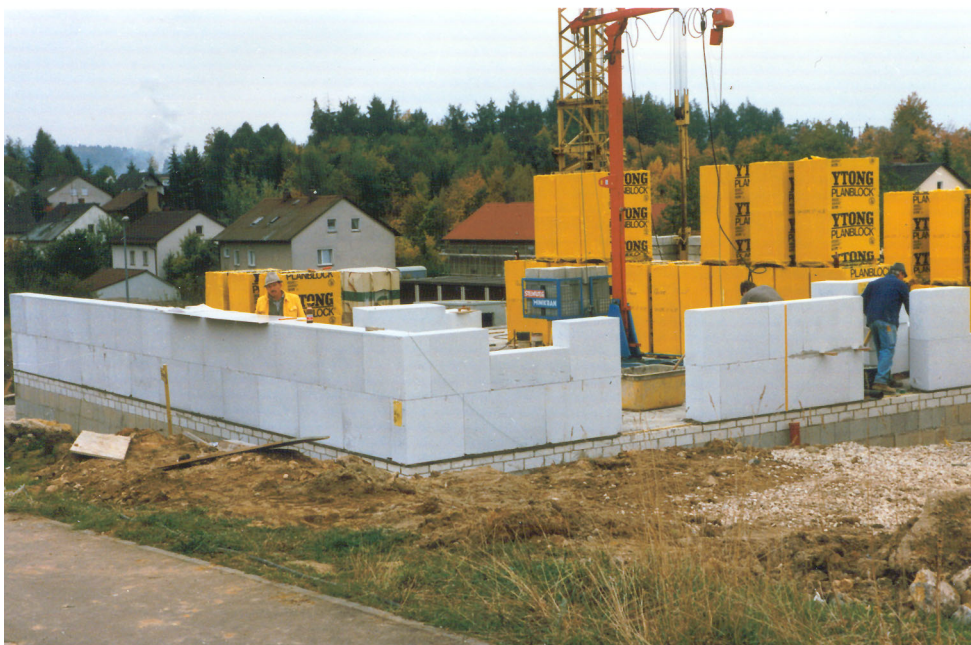
Рис. 1 Использование крупных блоков
