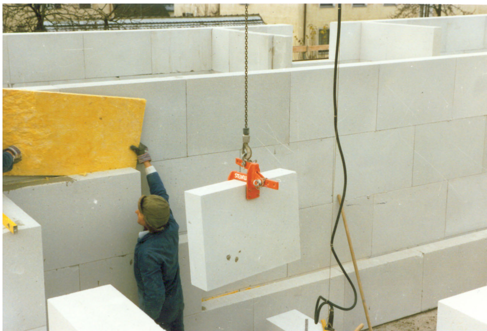
Рис. 2 Монтаж крупных блоков
