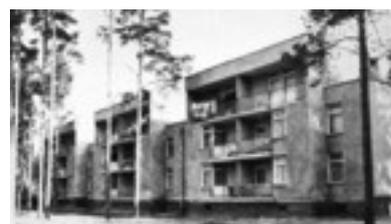
постройками, нашедшая широкое применение в Саратовской области ([рисунки 1.15, 1.16](#)). Стены выполнены из мелких газобетонных блоков, уложенных на растворе, с расшивкой швов, без наружной отделки, что значительно снижает стоимость строительства без ухудшения качества.
