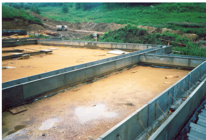
Рис.4. Заливка монолитного пенобетона в несъемную опалубку несущих стен.
