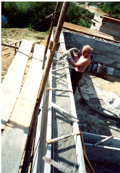
Рис.3. Установка первого ряда несъемной опалубки из конструкционного пенобетона несущих стен коттеджа.
