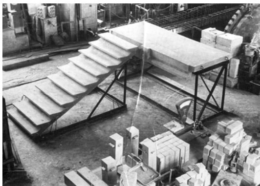
Рис.1. Консольный марш и площадка из поризованного бетона
