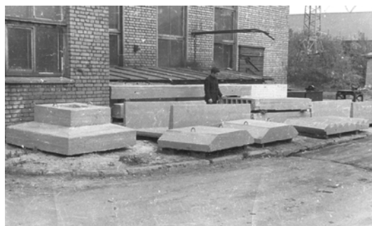
Рис.6. Экспонирование изделий из поризованного бетона. На переднем плане стакан-подколонник и фундаментные подушки.
