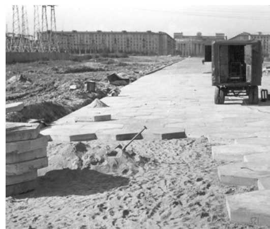
Рис.8. Строительство городской магистрали из поризованных плит по песчаной подсыпке (ул. Типанова).
