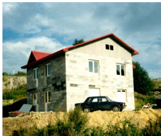
Рис.12. Общий вид коттеджа из монолитного пенобетона в несъемной опалубке (о.п. 150 м 2 ).
