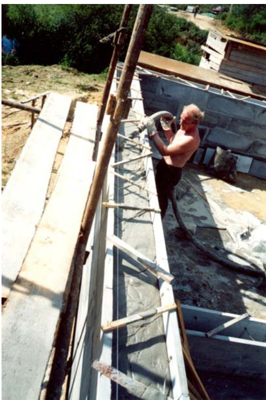
Рис.11. Заливка монолитного теплоизоляционного пенобетона в несъемную плитную опалубку из поризованного бетона (тяжелого пенобетона).
