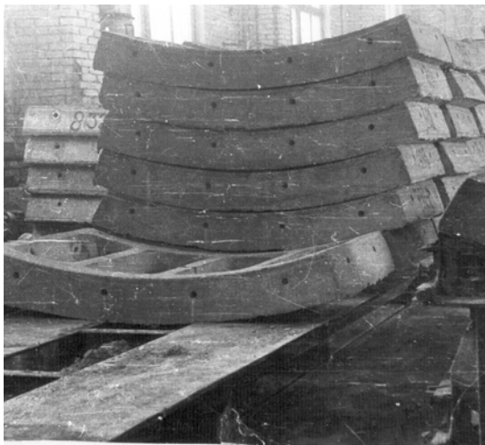
Рис.9. Секции туннелей метрополитена из поризованного высокопрочного бетона автоклавного твердения.
