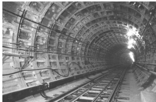
Рис.10. Вид туннеля из этих туннелей (Невско-Василеостровская линия).
